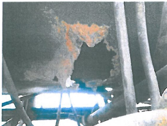
Skorodowana dolna część otuliny kotła w części walczaka
