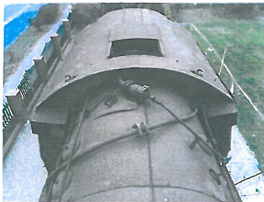
Górna część otuliny i dach budki maszynisty, widoczny główny zawór kolumny parowej oraz podstawa gwizdawk
