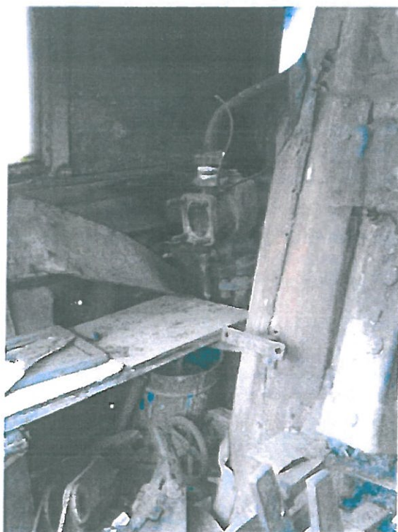
Ty2-1226 Stanowisko pomocnika maszynisty, pozostałości inżektora ssąco-tłoczącego Strubego
